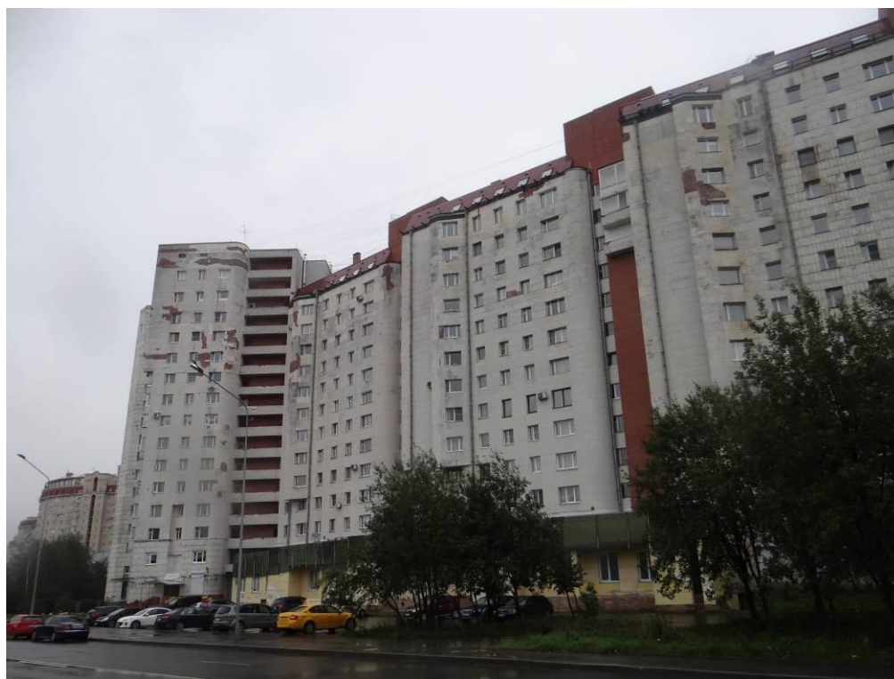
Рис. 2.1.2. Общий вид главного (юго-западного) фасада.
