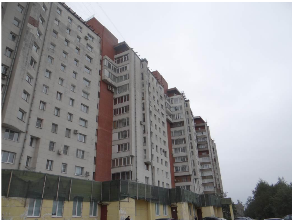
Рис. 2.1.3. Общий вид главного (юго-западного) фасада.
