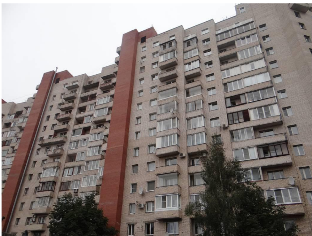
Рис. 2.1.5. Общий вид дворового (юго-восточного) фасада.
