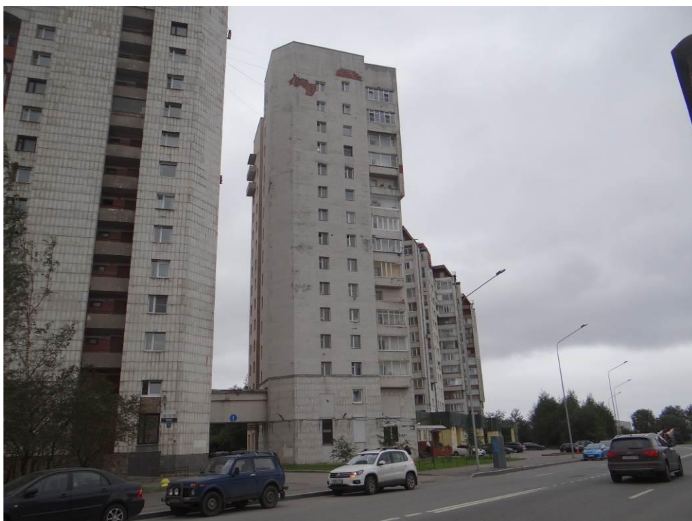
Рис. 2.1.4. Общий вид торцевого фасада (северного) крыла.
