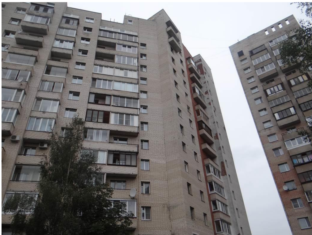
Рис. 2.1.5. Общий вид дворового (юго-восточного) фасада.
