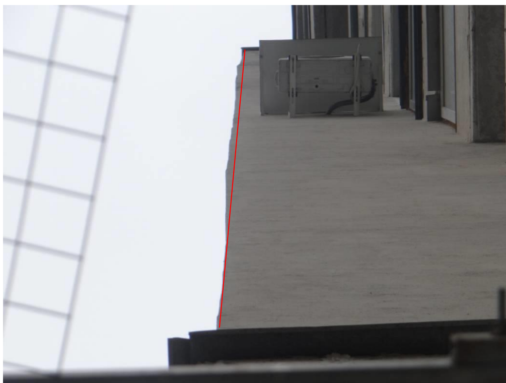
Рис. 3.1.18. Общий вид фасада по оси «В» (в плоскости рисунка) на угловом участке у оси «1» (из плоскости рисунка). Отклонение отдельных участков фасада от вертикали, локальные неровности.
